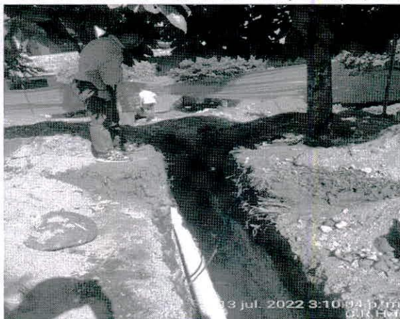
Visita de obra vías urbanas de Mariquita-13/07/2022
