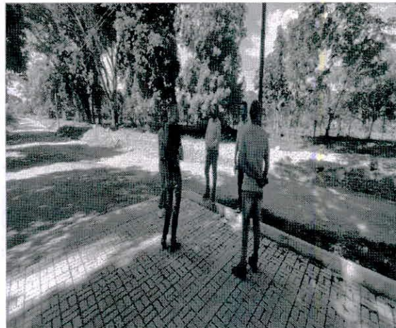
Visita de obra vías urbanas de Mariquita-13/07/2022
